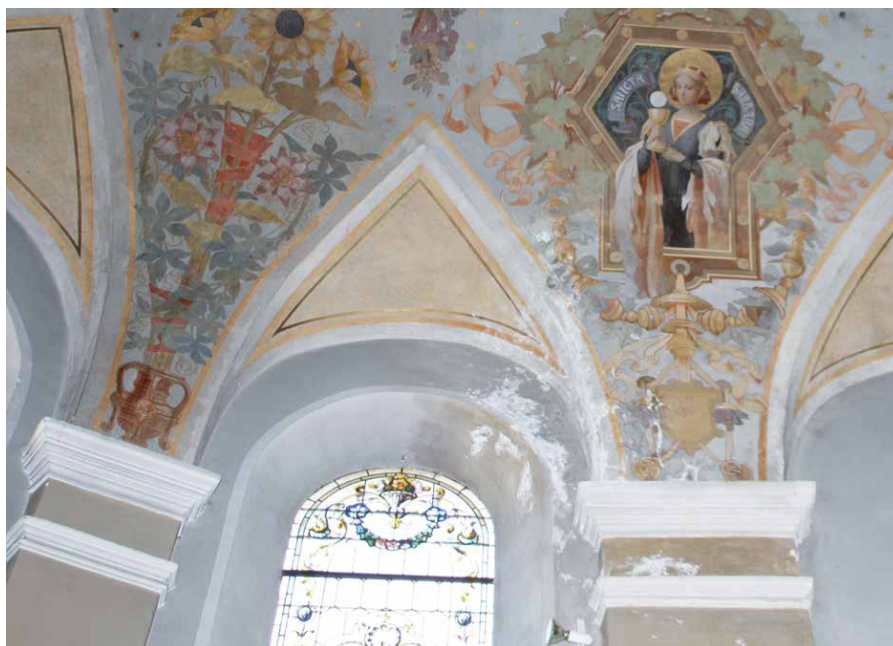
Wasserschäden an der Decke der Arzler Pfarrkirche
