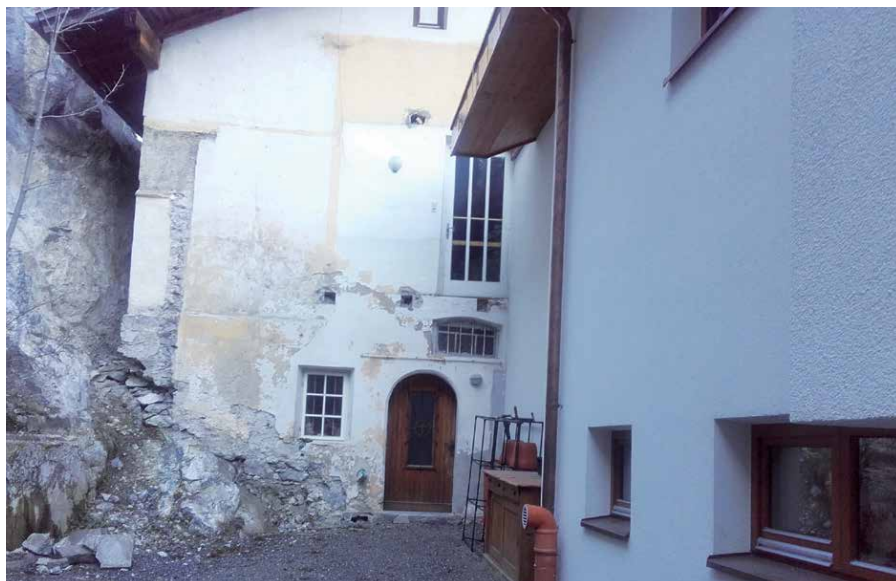
Die sanierungsbedürftige Westfassade des Widums
