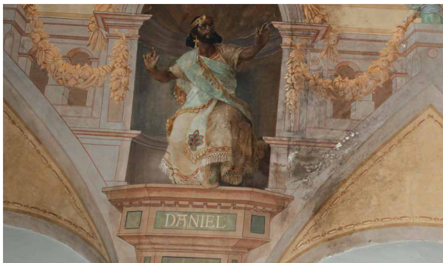
Auch hier sind große Wasserschäden sichtbar
