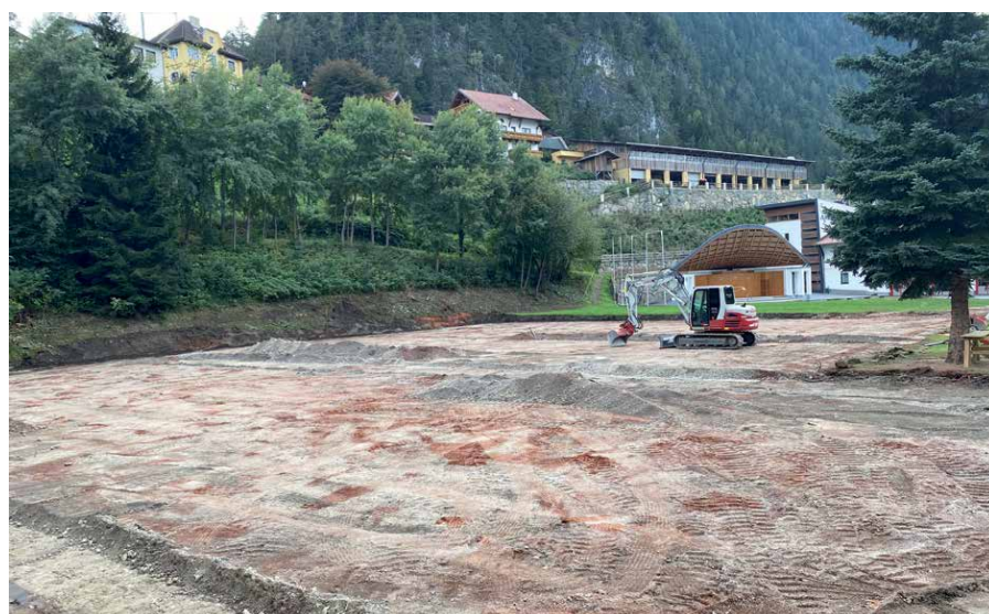
Abbruch der alten Tennisplätze
