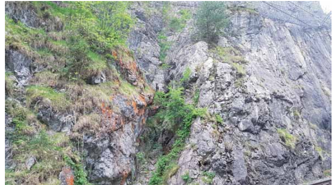
Steinschlagschutznetz oberhalb der Bahnleise.
