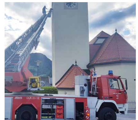
Reparatur der Uhrzeiger am Kirchturm.
