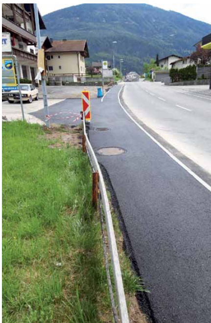
Eine weitere „Baustelle“ war der Gehweg im Bereich der Tankstelle. Aus Sicherheitsgründen wurde der Gehsteig angehoben und die Ein- bzw. Ausfahrten abgesenkt. Alle Arbeiten wurden in kompletter Eigenregie unseres Bauhofs durchgeführt.
