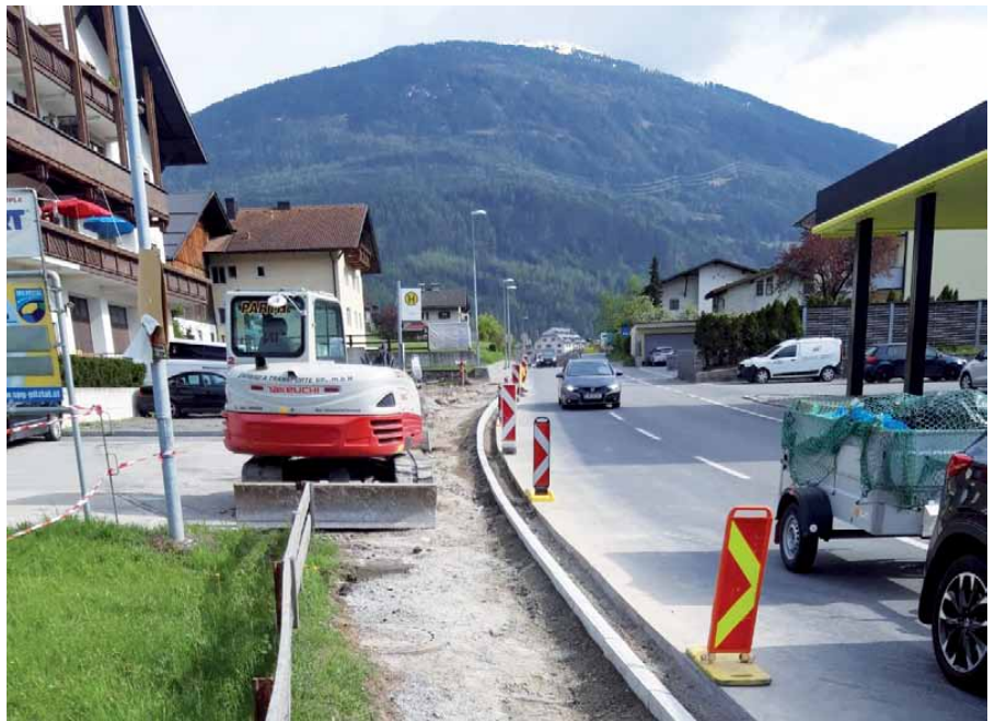
Eine weitere „Baustelle“ war der Gehweg im Bereich der Tankstelle. Aus Sicherheitsgründen wurde der Gehsteig angehoben und die Ein- bzw. Ausfahrten abgesenkt. Alle Arbeiten wurden in kompletter Eigenregie unseres Bauhofs durchgeführt.
