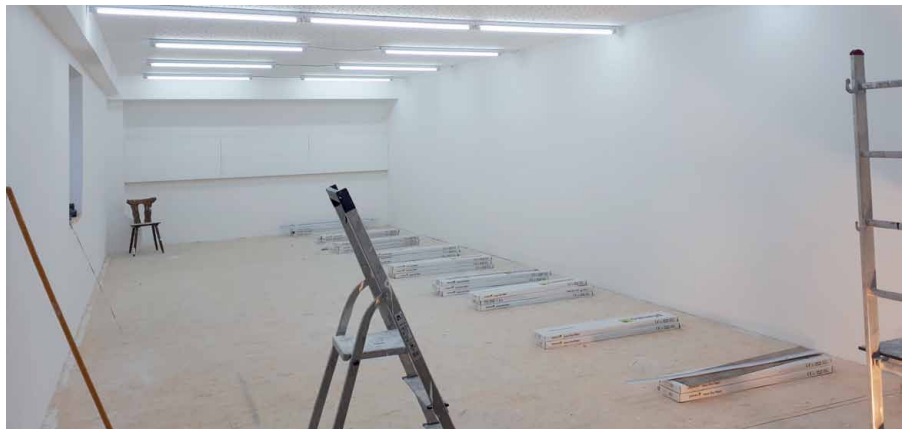
Kleiner Einblick beim Umbau
