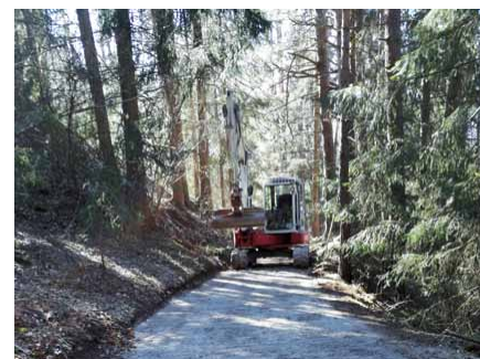
Sanierungsarbeiten Pitztal Bike Arzl Wald
