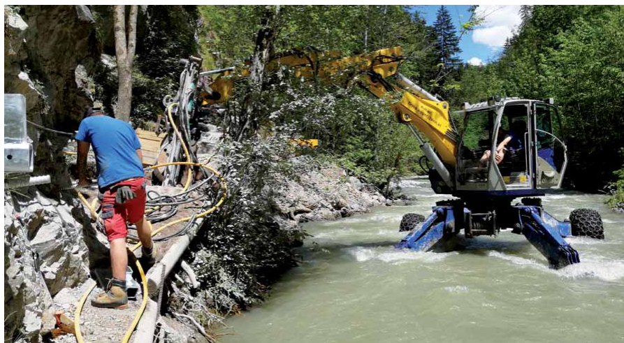
Baggerarbeiten Luis Trenker Steig
