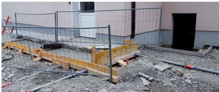
Arzl, Baustelle Eingang Schützenheim
