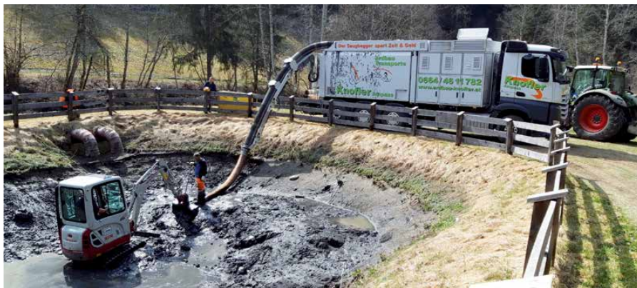
Instandhaltungsarbeiten Überlaufbecken
