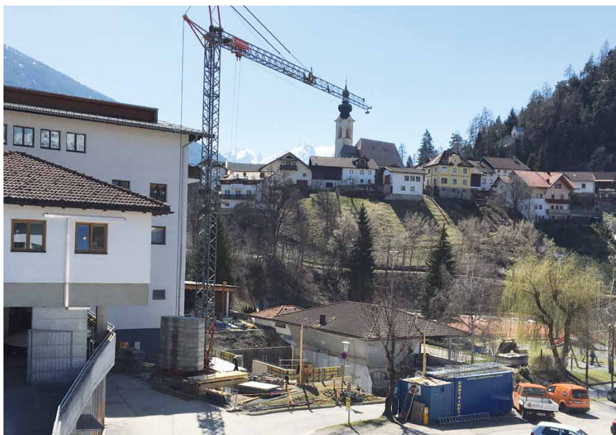
Hinter dem Gemeindehaus tut sich derzeit eine große Grube auf: die Aushubarbeiten für die neue Mikronetzanlage starteten Anfang März. Foto: Schnegg
