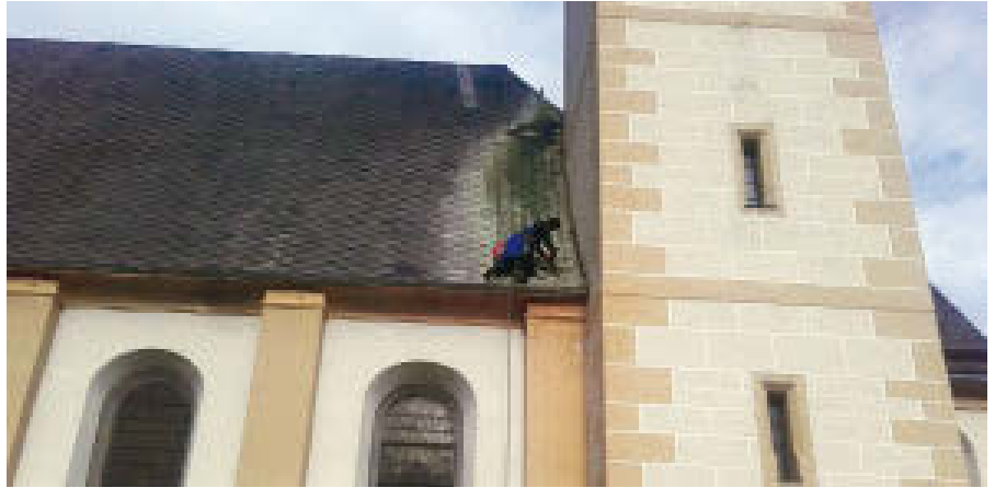
Das Kirchendach wird notdürftig repariert.
