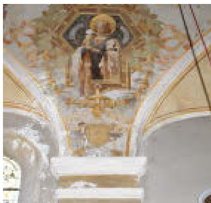
Durch das undichte Dach sind im Innenraum schon Wasserschäden an Fresken und Mauerschäden erkennbar.
