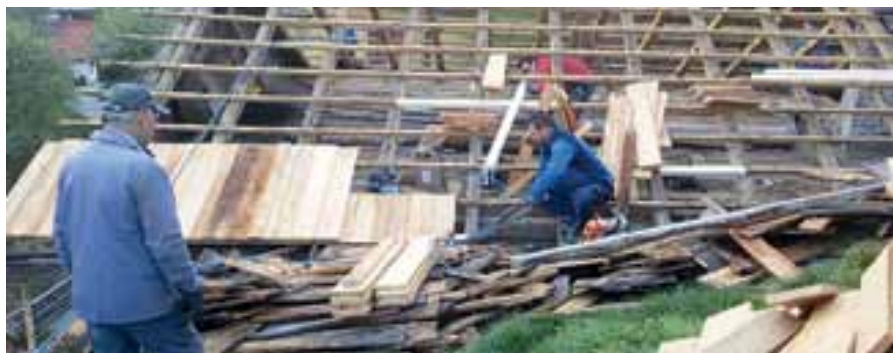
Beginn: Erst mussten noch einige Dachlatten erneuert werden.
