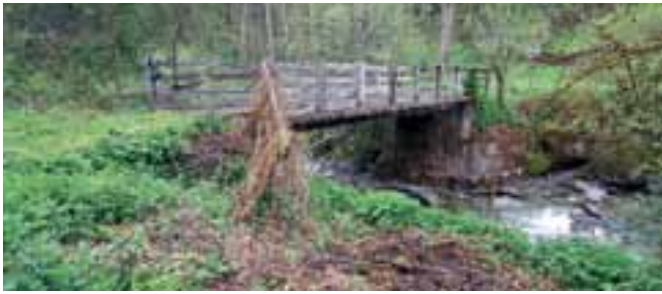
Im Juli wurde vom Gemeindebauhof die Brückensanierung in Blons abgeschlossen.
