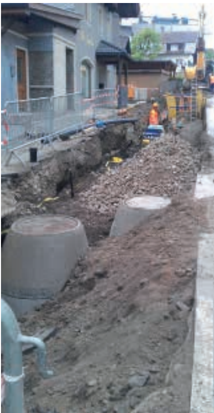
Bauarbeiten im Bereich Pitztalstraße L 16.
