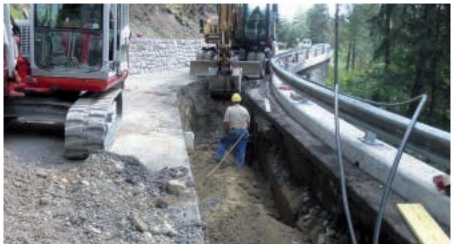
Bauarbeiten im Bereich Jerzener-Landesstraße.
