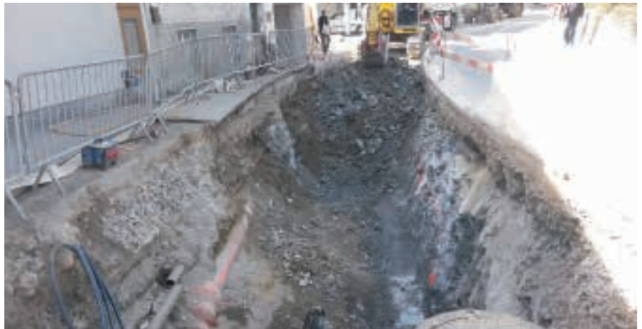
Bauarbeiten im Bereich Pitztalstraße L 16.
