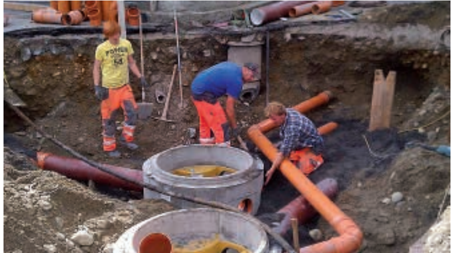
Bauarbeiten im Bereich Schwalbengasse/Burgstallweg.
