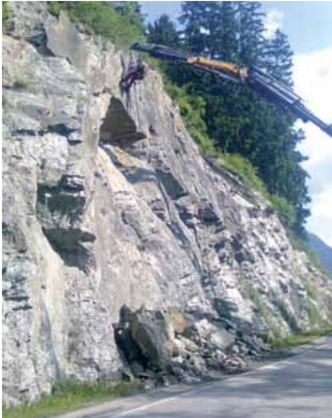
Die Straßenmeisterei beauftragte die Firma HTB mit der Felssicherung.
