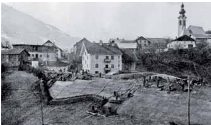
Straßenbau um 1916/17. Arbeiter waren russische Kriegsgefangene, die in einer Baracke bei der früheren Agrarsäge im Dorf untergebracht waren.
