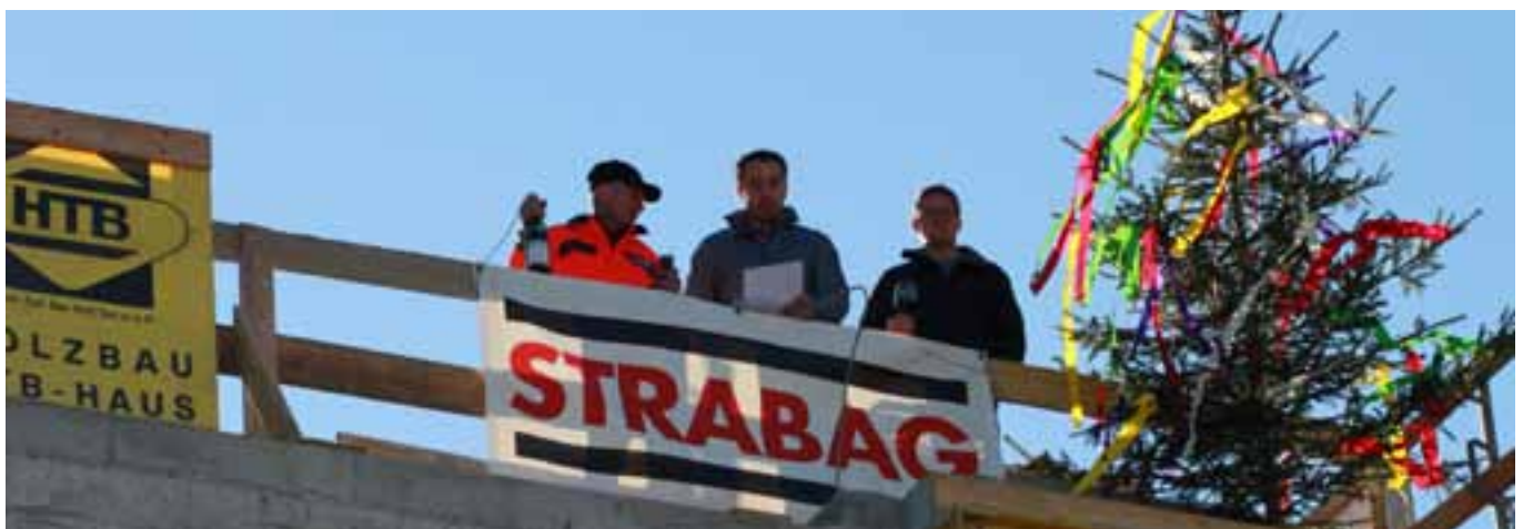
v.l.n.r. Polier Herbert Gasser, Techniker Benjamin Wöber und Bauleiter Thomas Köll beim Firstspruch.
