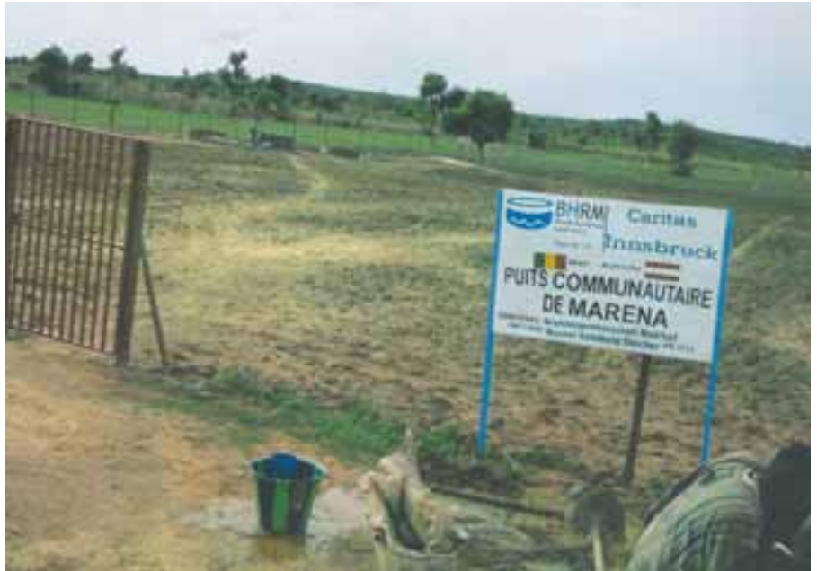
An den Brunnenprojekten in Mali wird bereits gebaut.
