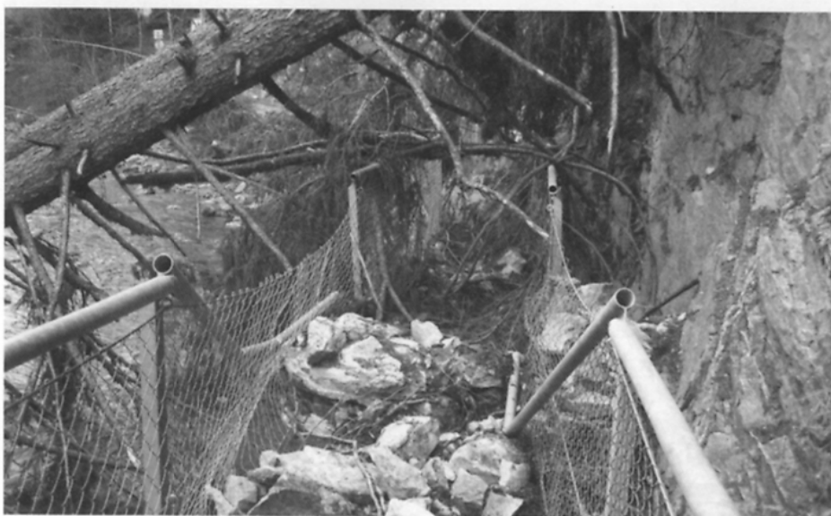
Der Luis-Trenker-Steig wurde im vergangenen Winter stark beschädigt. Foto: TVB Pitztal
