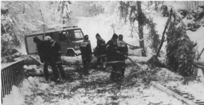
Die Brücke von Arzlair die durch eine sehr große Fichte beschädigt wurde.
