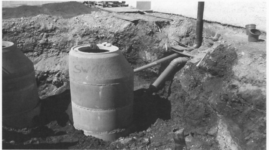
Wasser- und Kanalgrabarbeiten Schwalbengasse.
