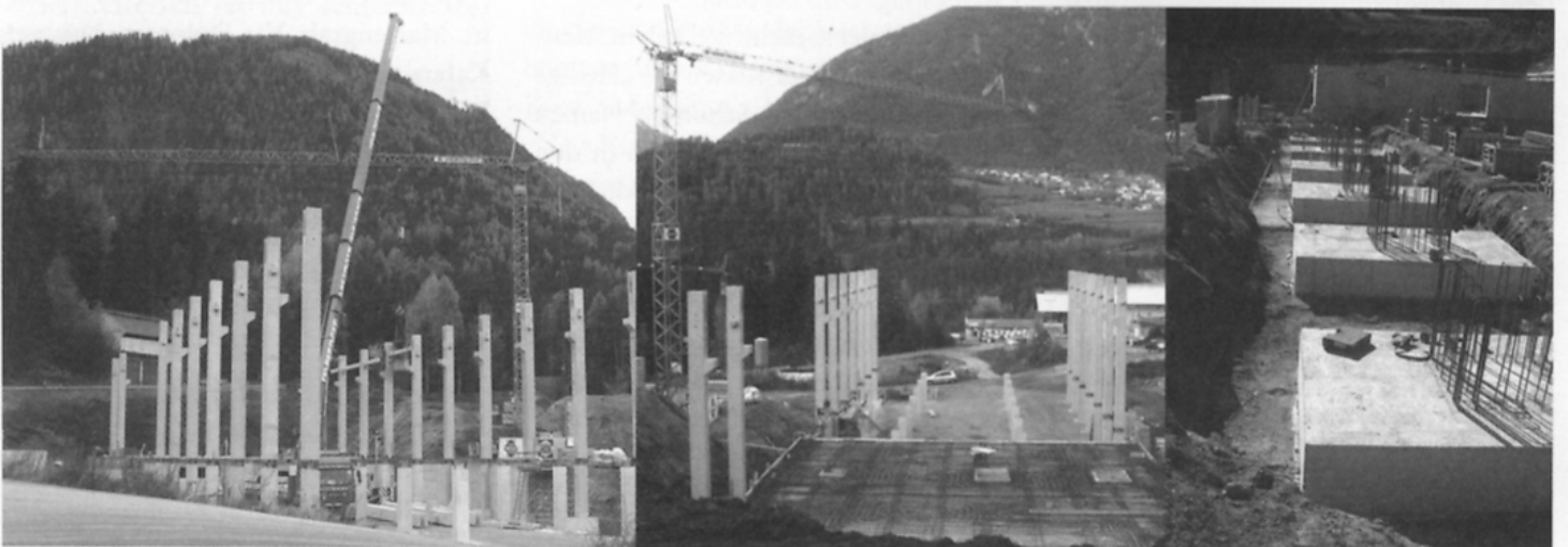
Einge Bilder aus der Bauphase.
