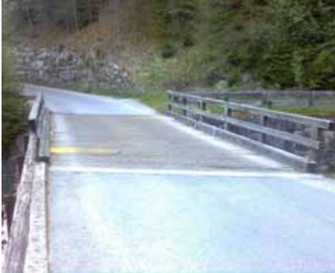
Im Laufe der Zeit haben sich Verschleißerscheinungen beim hölzernen Fahrbelag und beim Geländer bemerkbar gemacht. Fotos: Gemeinde
