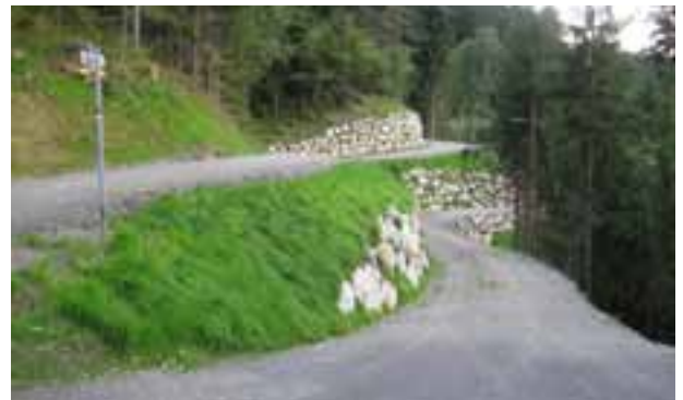
Im Bereich der Abzweigung zum Wasserschloß konnte der Weg nur mit Steinmauern gesichert werden. Fotos: Gemeinde
