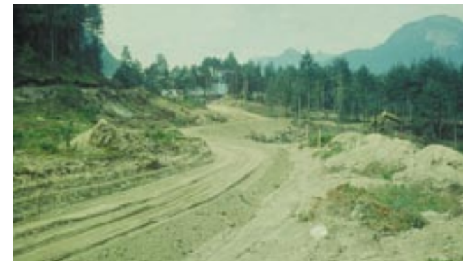
Wegbau in der „Unter-Siedlung“ Anfang 1980
