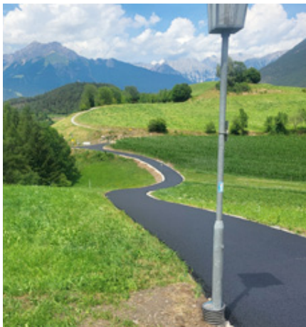
Fertiggestellter neu asphaltierter Weg nach Abschluss der Bauarbeiten
