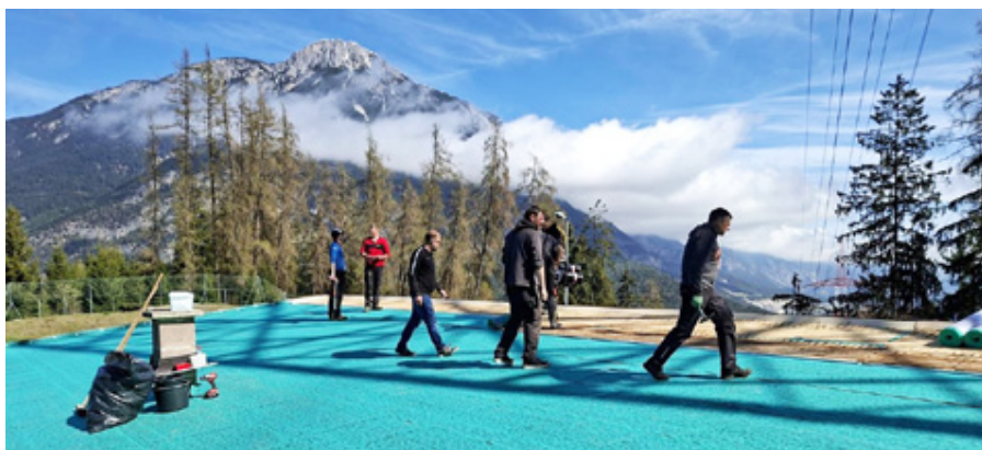
Dachsanierung am Vereinshaus
