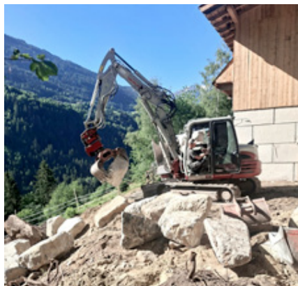
Straße während den Sanierungsarbeiten
