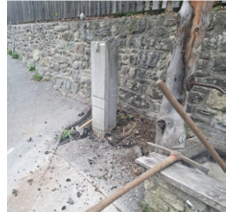
Brunnen während der Sanierungsarbeiten
