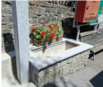
Fertig sanierter Dorfbrunnen mit neuem Brunnensäulenstock
