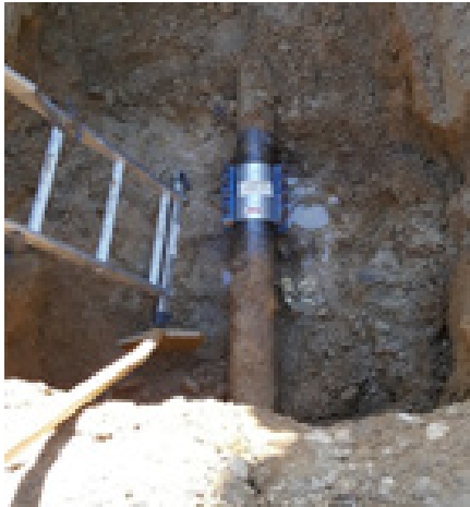
Wasserrohrbruch im Bereich Osterstein
